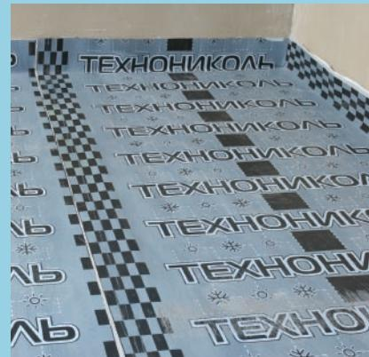
Техноэласт АКУСТИК-СУПЕР заводится на вертикальные поверхности до уровня чистого пола. В результате мы получим надежное покрытие, защищающее помещение как от ударных шумов, так и от риска затопления соседей снизу.
