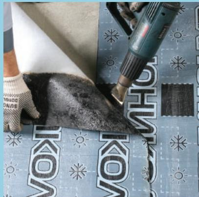
Формируя торцевой (поперечный) нахлест, необходимо снять звукоизоляционный слой 150 мм. Все нахлести сплавляются горячим воздухом при помощи строительного фена.
