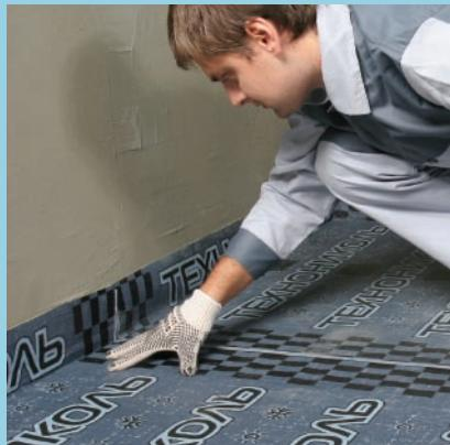
Материал укладывается звукоизоляционным слоем к основанию с заведением на вертикаль до уровня финишного покрытия - чистого пола.
