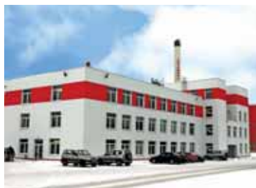
г. Выборг, Ленинградская обл.
