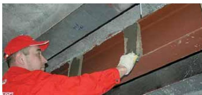
Заготовленные заранее части основной огнезащитной облицовки крепятся к вставкам при помощи гвоздей. Гвозди фиксируют облицовку на время высыхания клея. Их количество составляет 2–3 штуки на вставку.
