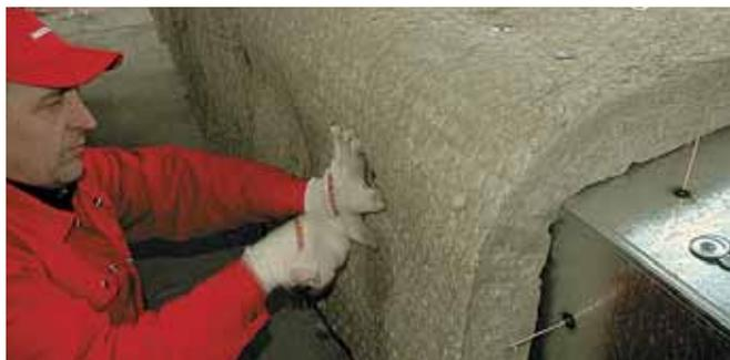
2. Воздуховод оборачивается матами Wired Mat 80, а крепление осуществляется непосредственно через покрытие. В качестве элементов крепления в данном случае комбинированные штифты CDF и CDF-ISOL (игла уже соединена с шайбой).
