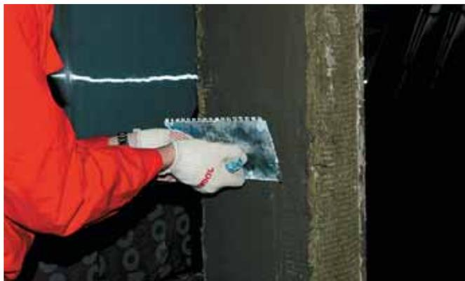
Утапливание армирующей стеклотканевой щелочестойкой сетки в нанесенный раствор. В случае применения плит Conlit SL 150 с покрытием из стеклотсетки, данная операция не требуется. Для достижения более высокого уровня ударной прочности все наружные углы армируются специальным профилем из ПВХ сетки. Расход сетки на 1 м<sup>2</sup> составляет 1,15 м<sup>2</sup>.
