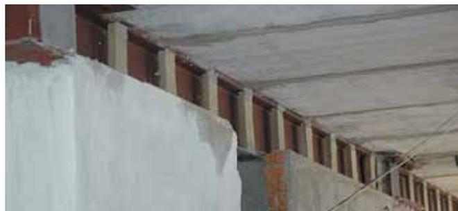
На лицевую сторону закрепленных вставок с одной стороны стенки двутавра наносится клей Conlit Glue слоем не менее 2 мм толщиной.
