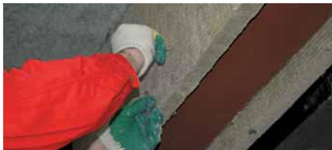
На ту часть облицовки, которая предназначена для монтажа, со стороны полки двутавра наносится клей Conlit Glue как на торцевые части, так и на лицевую.
