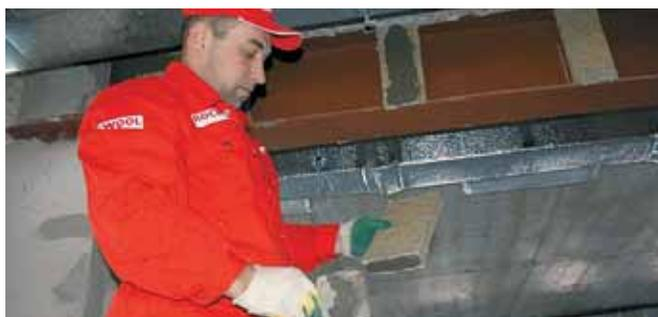
Вставки закрепляются в распор между полками двутавра. При этом вставки должны немного выступать за концы фланцев.
