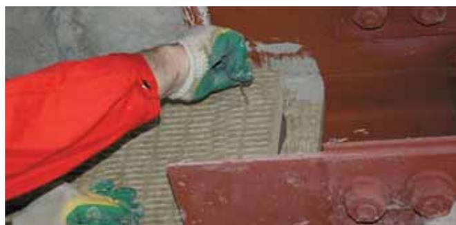
На торцевые стороны заранее заготовленных частей огнезащитного покрытия, предназначенных для облицовки полок двутавра, наносится клей Conlit Glue толщиной слоя не менее 2 мм.
