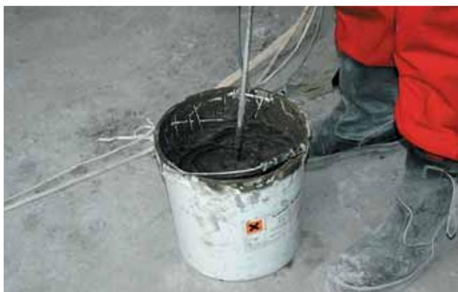
При работе остаток свежего клея смывается водой, т.к. засохшие остатки могут быть удалены только механическим способом.
