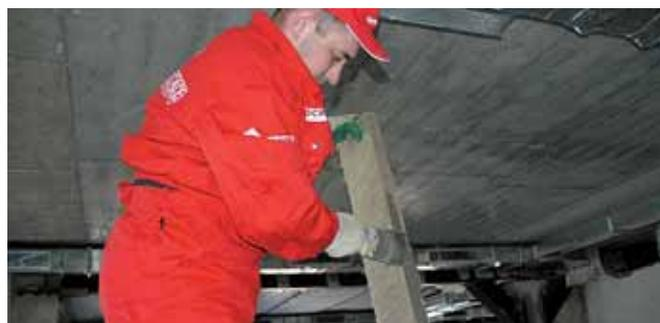
Подготовленные части облицовки с нанесенным на них клеем фиксируются со стороны полок двутавра на уже смонтированные плиты при помощи гвоздей. Длина гвоздей должна быть в 2 раза больше толщины применяемого материала.
