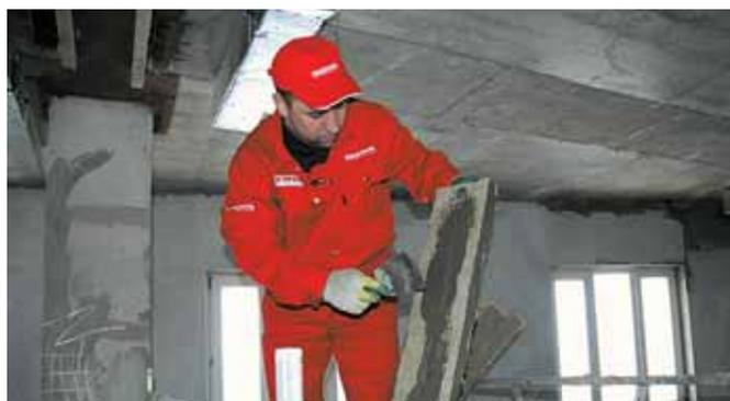
Подготовленная часть облицовки прикладывается со стороны полки двутавра и фиксируется при помощи гвоздей с закреплением в части облицовки. После высыхания клея гвозди удаляются либо их шляпки укрываются слоем клея Conlit Glue.
