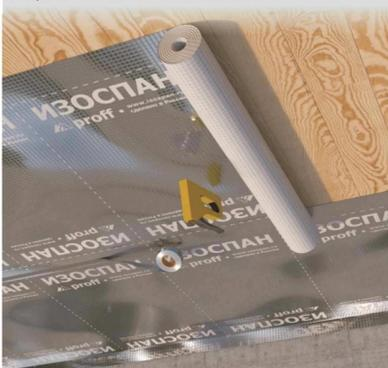
2 Места примыканий отражающей пароизоляции Изоспан RF к деревянным, бетонным и прочим поверхностям необходимо проклеивать соединительной лентой Изоспан ML prof или Изоспан KL+.
