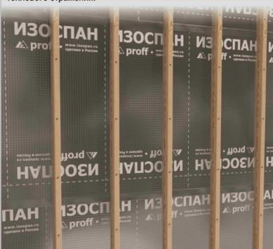
Вариант конструкции каркасной стены
