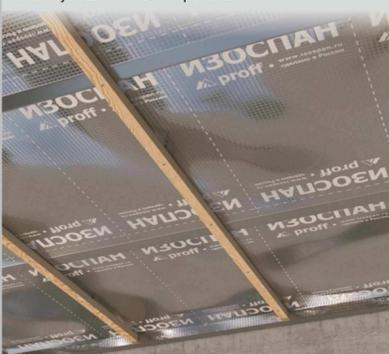
Вариант конструкции чердачного и межэтажного перекрытия
