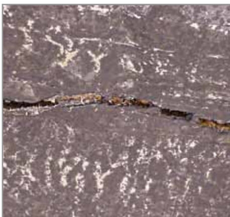
Материалы с неэластичной основой при перепаде температур подвержены образованию трещин.
