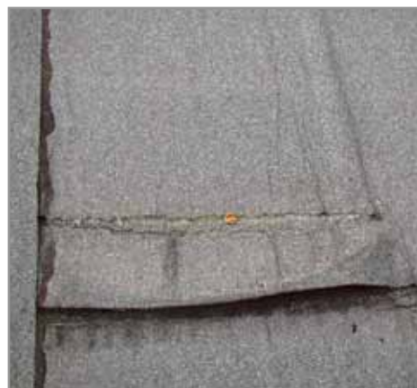
Расслоение швов из-за применения материала с низкими показателями разрывных характеристик.
