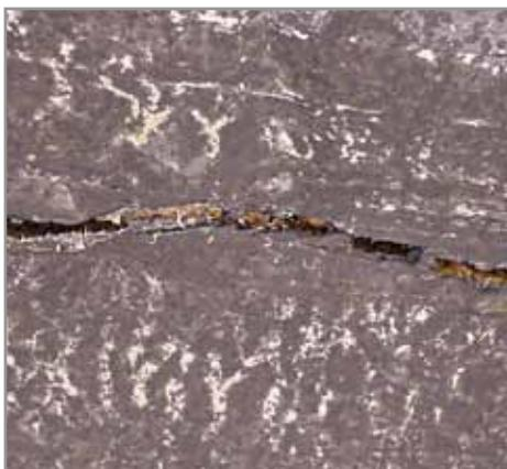
Материалы с неэластичной основой при перепаде температур подвержены образованию трещин.
