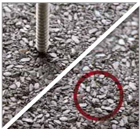
Тонкий материал спустя 15 лет. С течением времени легкие фракции битума «испаряются» с поверхности под воздействием ультрафиолетового излучения и теплового воздействия.
