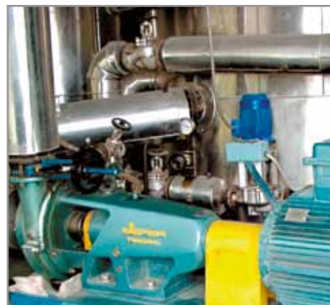
Гомогенизатор позволяет добиться высокого качества битумно-полимерной смеси.
