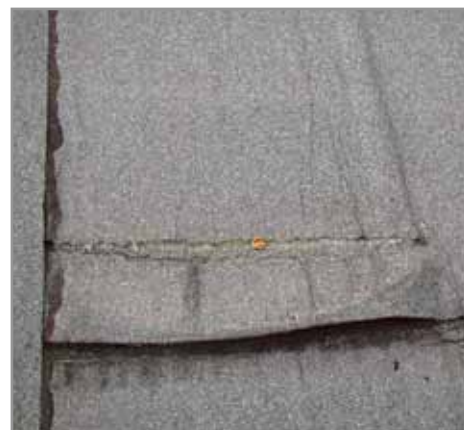
Расслоение швов из-за применения материала с низкими показателями разрывных характеристик.
